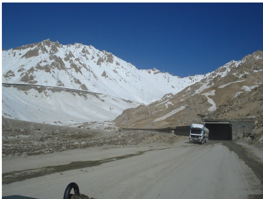
Vers le Tunnel de Salang, vu dans l'autre sens...
